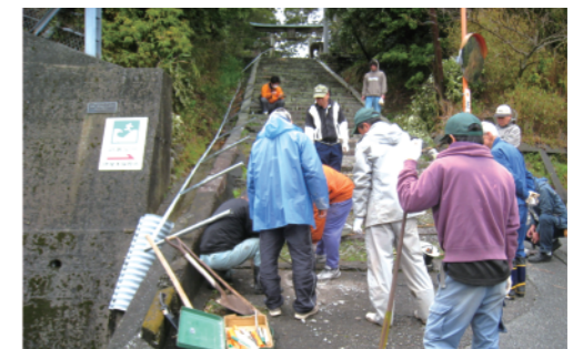
自主防災組織による避難路整備(安芸市)
