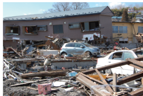
写真 東日本大震災の被災状況(宮古市)
