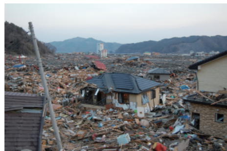
写真 東日本大震災の被災状況(大槌町)
