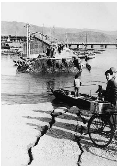
揺れによる堤防の決壊 高知市葛島堤防付近
