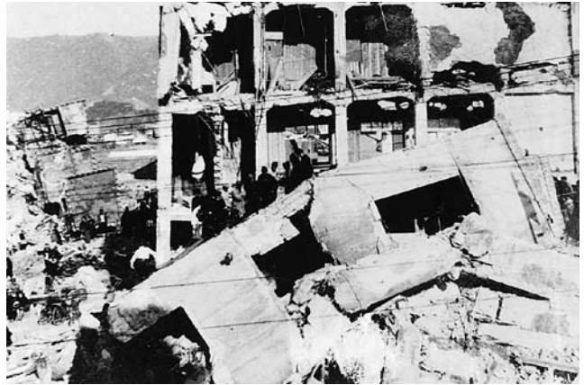
ビルの倒壊 高知市堺町付近
