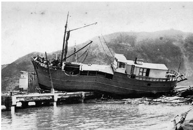
津波によって打ち上げられた船 須崎市港町付近（提供 須崎市）
