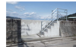
コンクリートによる陸こうの閉鎖
