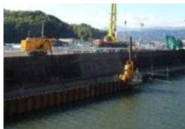
河川堤防の耐震対策
