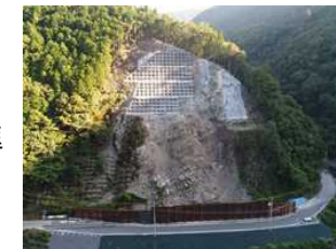
安田東洋線 (安田町平瀬地区)
