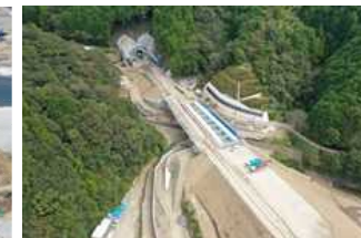
E56四国横断自動車道 窪川佐賀道路 (黒潮町)
