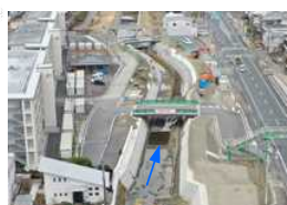
宇治川（堤防整備）
