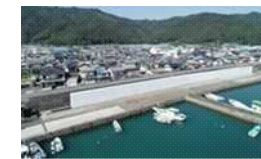
海岸堤防の耐震補強状況
