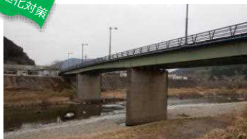
国道381号 窪川橋
