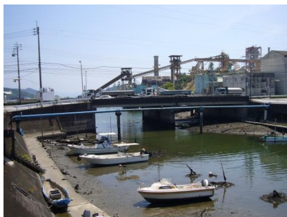
鏡川工業用水道 孕水管橋と港地区の様子
