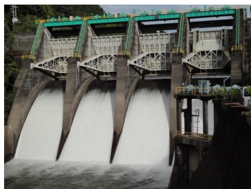
杉田ダム 洪水吐ゲート
