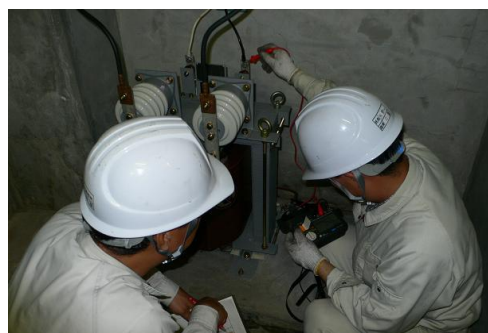
発電所保守点検の様子
