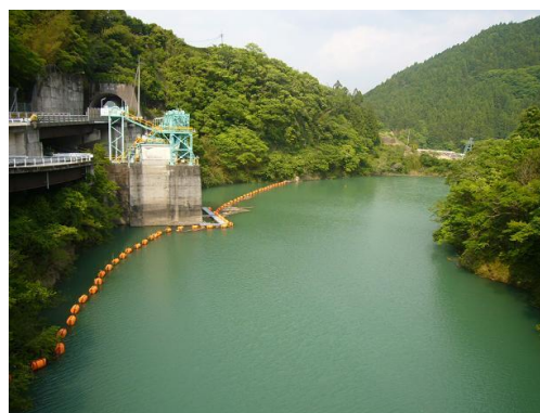
永瀬発電所 取水口
