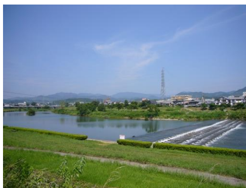
鏡川工業用水道 送水ポンプ場前の状況
