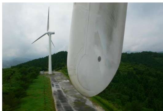
浦喜ヶ峰風力発電所
