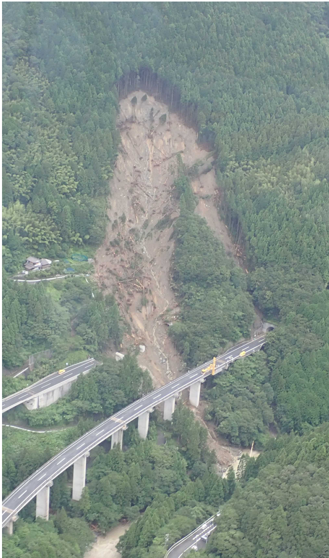
高知自動車道（大豊町）崩落現場
