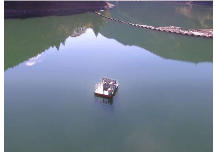
▲自動濁度計 全景
