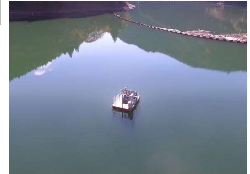
▲自動濁度計 全景
