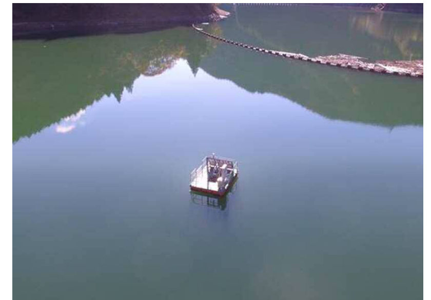
▲自動濁度計 全景
