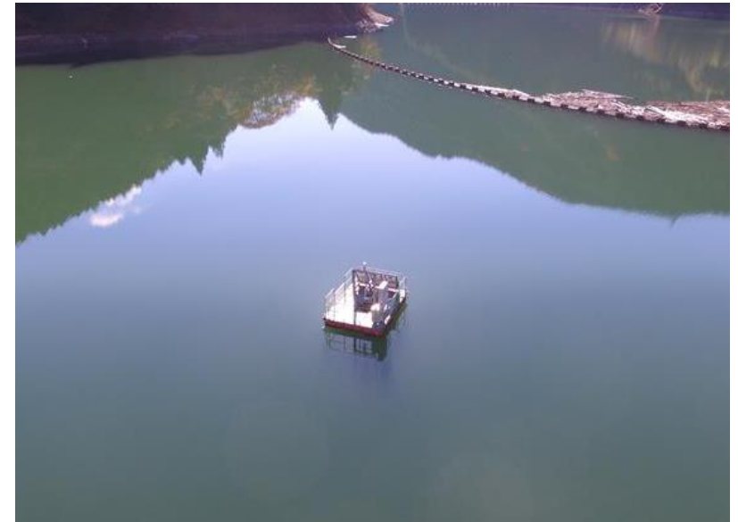
▲自動濁度計 全景
