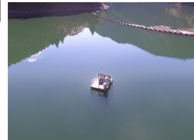
▲自動濁度計 全景
