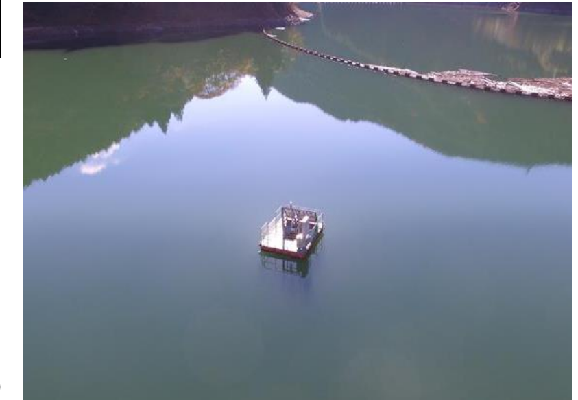
▲自動濁度計 全景
