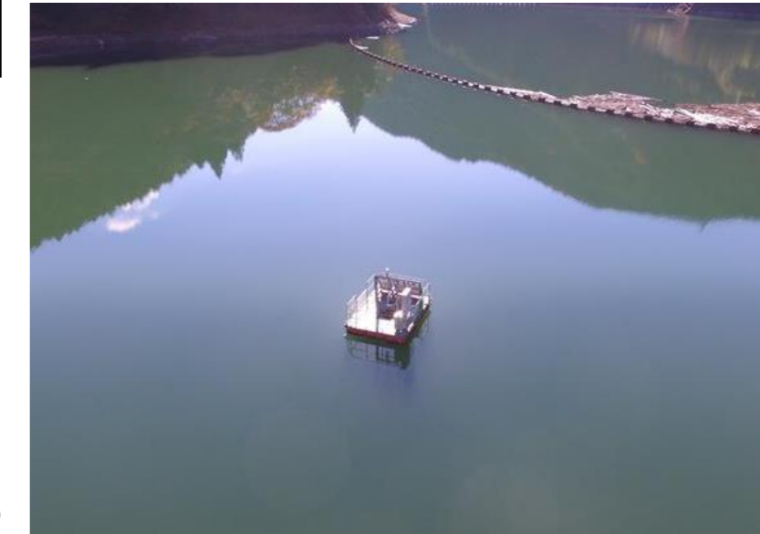
▲自動濁度計 全景
