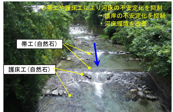
帯工設置箇所(工事完了6か月後)
