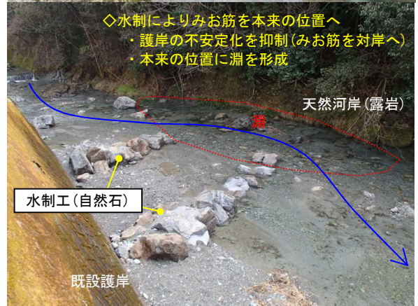
水制設置箇所(工事完了直後)
