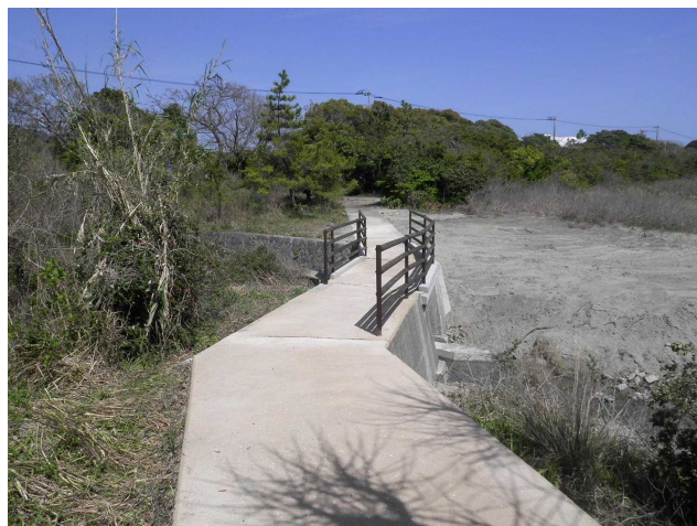
竜串園地遊歩道改修工事
