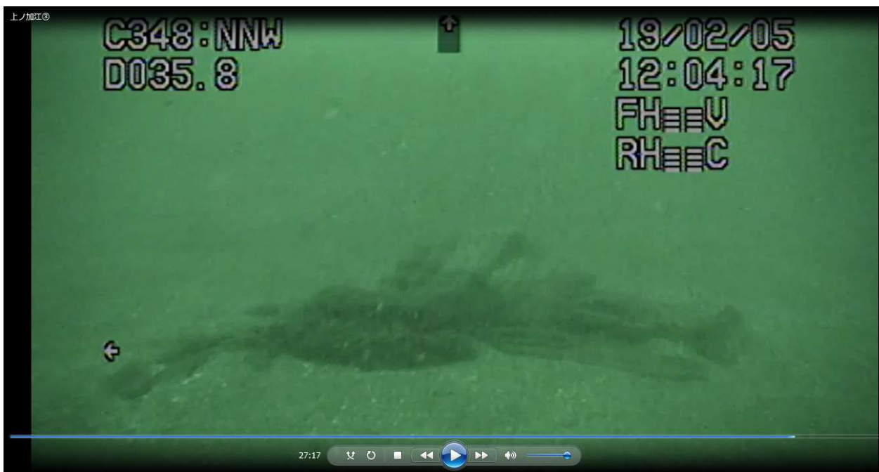
砂の抜けた土俵袋の残骸。ロープは埋もれている様子。
