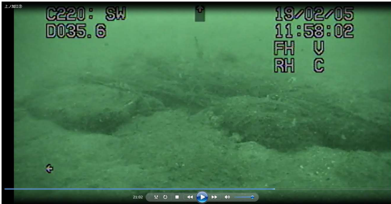
土俵の残骸からはロープが長く伸びている。土俵はほとんど埋まっている状態。
