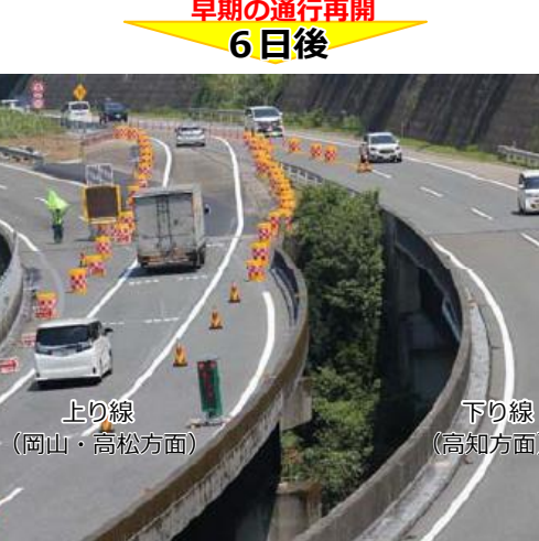
▲対面通行による通行再開状況 (大豊IC付近)
