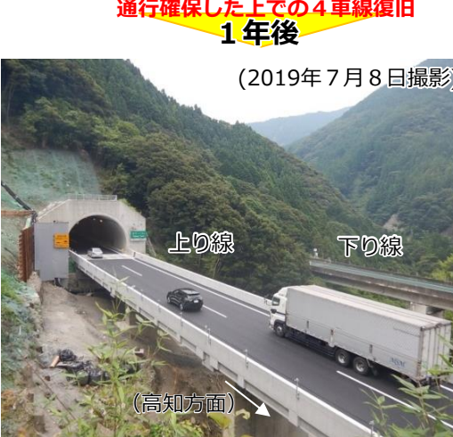
▲4車線による通行再開状況 (立川橋IC付近)
