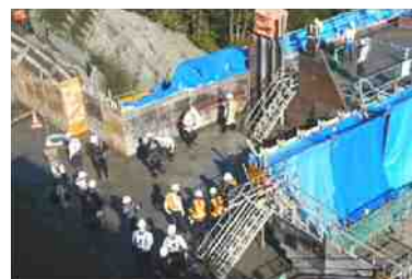
堤体上部より
