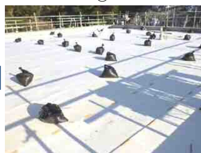
保温マット敷設完了②
