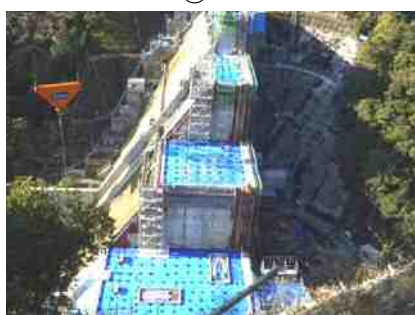
ブルーシート敷設完了②(左岸から)
