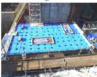
ブルーシート敷設完了①
