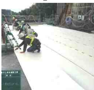
保温マット敷設状況
