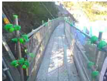
スロープ通路(勾配をつけ、階段部を少なくしている)
