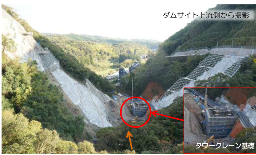
ダムサイト下流側から撮影
