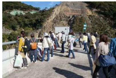
現場見学状況
