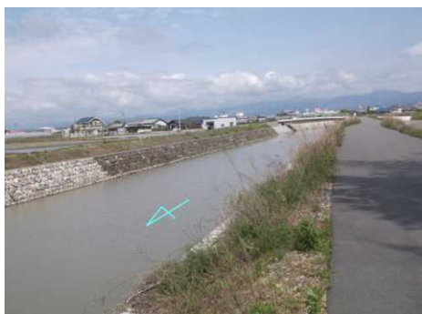
改修済区間 【烏川 現況】
