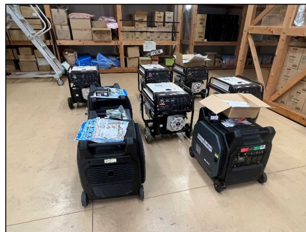
香南市備蓄倉庫（発電機）
