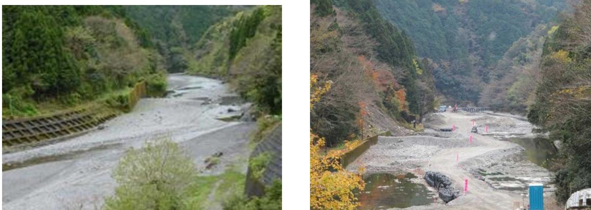
図 4.11 永瀬ダム貯水池における堆砂状況（左）及び堆積土砂の掘削状況（右）
