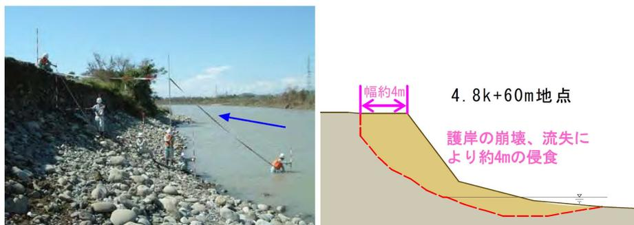
平成16年8月、10月洪水による低水護岸の崩壊、流失
