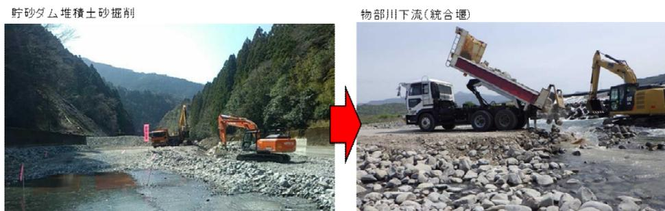
統合堰の復旧状況（ダム貯水池の堆積土砂を利用）
