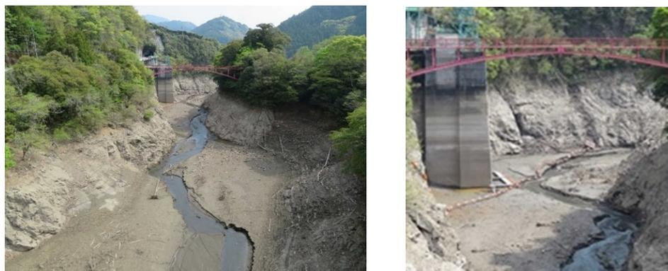
図 4.12 永瀬ダム貯水池の発電取水口周辺における堆砂状況
