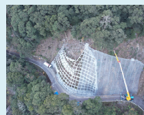
法面防災対策 (県道清王新田貝ノ川線)
