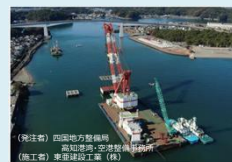
三重防護事業 (湾口防波堤)
