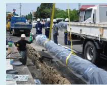
上水道管路の耐震化
