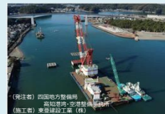
三重防護事業 (湾口防波堤)
