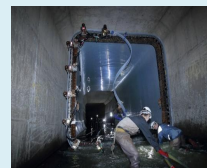
下水道管路の耐震化
