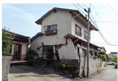
〔平成28年熊本地震での住宅被害〕
