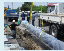
上水道管路の耐震化
