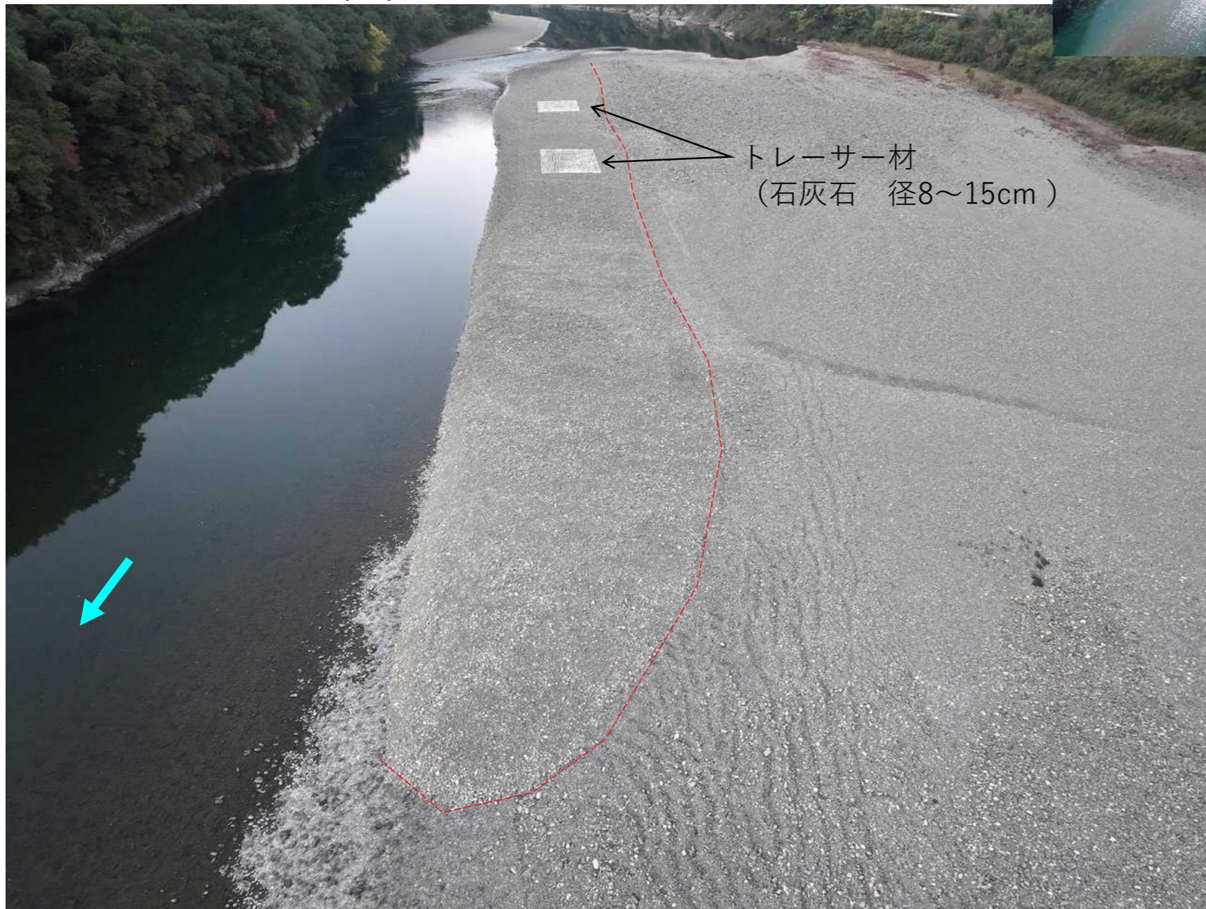
試験施工（置土）後2024/12/03
