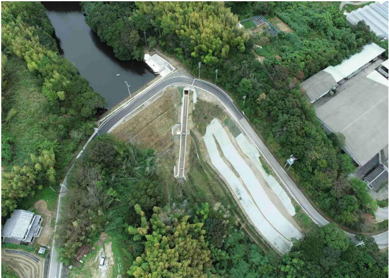
ため池改修工事(六丁池) 洪水吐工 L=83.8m
