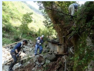
電気柵の設置作業
