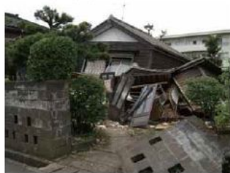
【全壊】 一見して住家全部が倒壊
