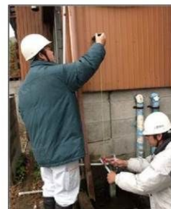
（住宅の傾斜の計測）
