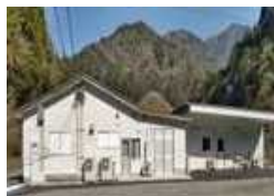
○本川手箱きじ飼育処理加工施設 改修 R2.11月落成 地域AP No.5 R2年度産振補助金
