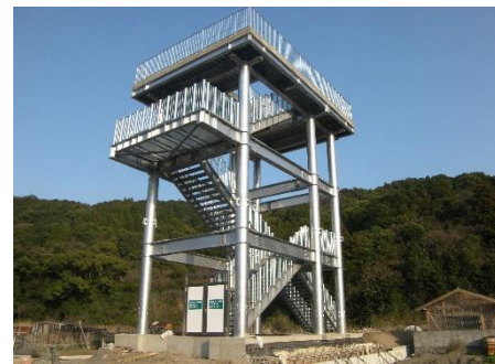
津波避難タワー(四万十町)
