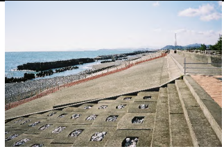
②護岸状況
