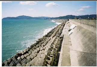
③護岸状況
