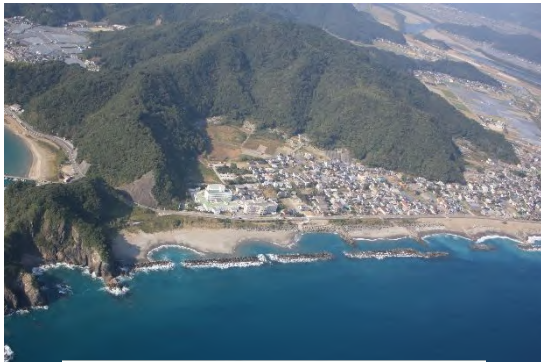
〔侵食対策事業の状況（新居海岸）〕
