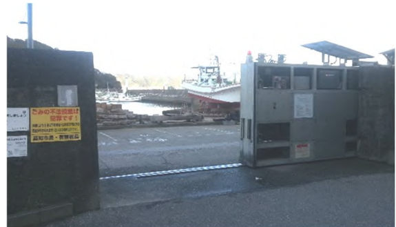
〔陸閘機械化 事例〕
