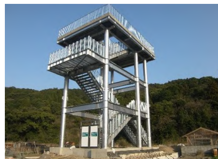
〔津波避難タワー（四万十町）〕
