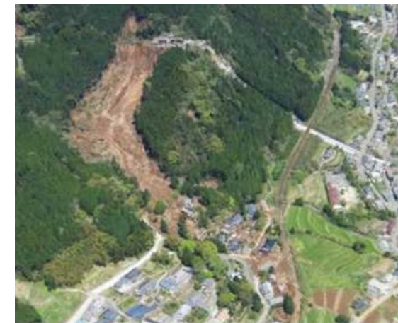
平成28年熊本地震による立野川地区（南阿蘇村）の被害
