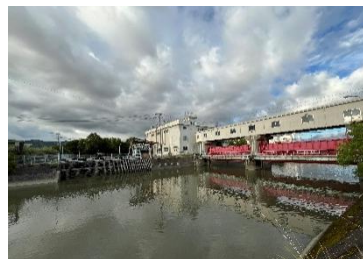
▲江の口川排水機場
