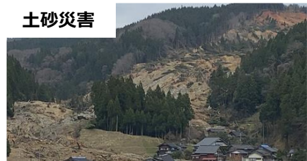
輪島市 撮影:令和6年4月
