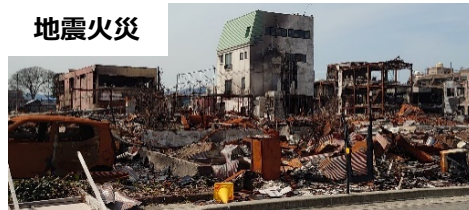
輪島市 撮影:令和6年4月
