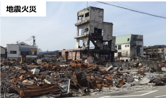
輪島市河井町朝市地区 撮影：令和6年4月
