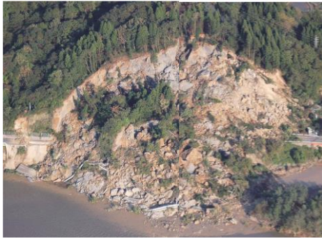
出典:新潟県農地部農地管理課 新潟県中越大震災～農地・農業用施設の復旧復興に向けて(写真集)～
