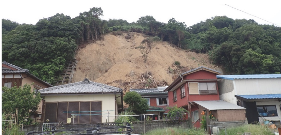
土砂災害特別警戒区域で発生した土砂災害（平成 30 年 7 月豪雨）
