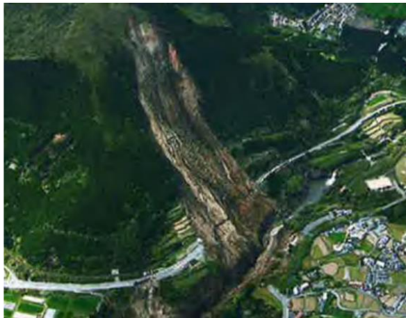
大規模斜面崩壊による主要道路の寸断
