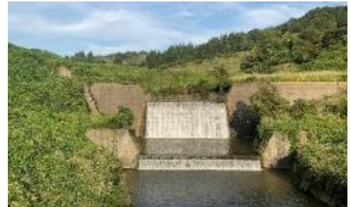
旧山古志村東竹沢地区の砂防堰堤
