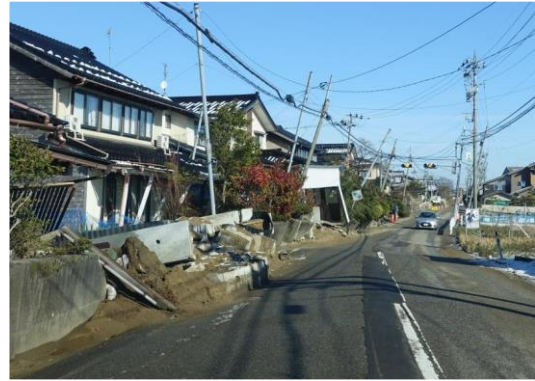
石川県内灘町内での液状化現象
