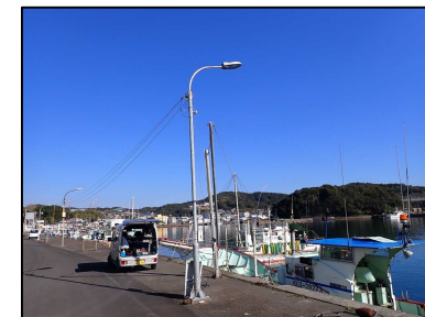
漁港施設照明の省エネ化
