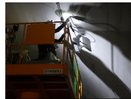
トンネル照明のLED化の様子
