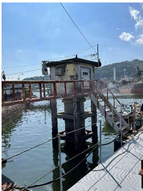
【検潮儀（潮位観測装置）設置箱 （高知市棧橋通）】
