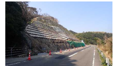
落石対策工事
