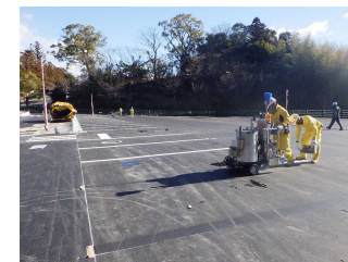
駐車場の整備
