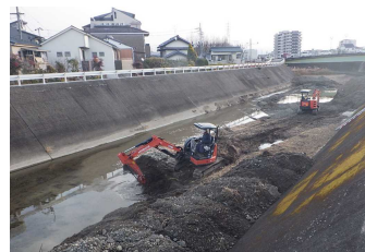
久万川浚渫工事
