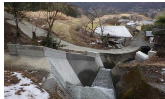
高須地すべり対策工事
