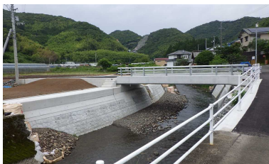
和食川改修工事
