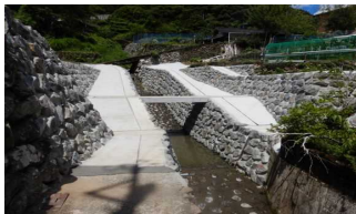
中鴨川砂防工事
