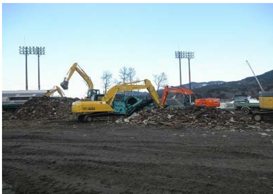
▲重機による粗選別の例 宮古市運動場跡前(平成 24 年 2 月 16 日)
