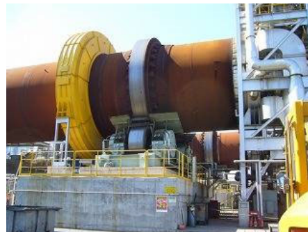
▲石巻ブロックのロータリーキルン炉
