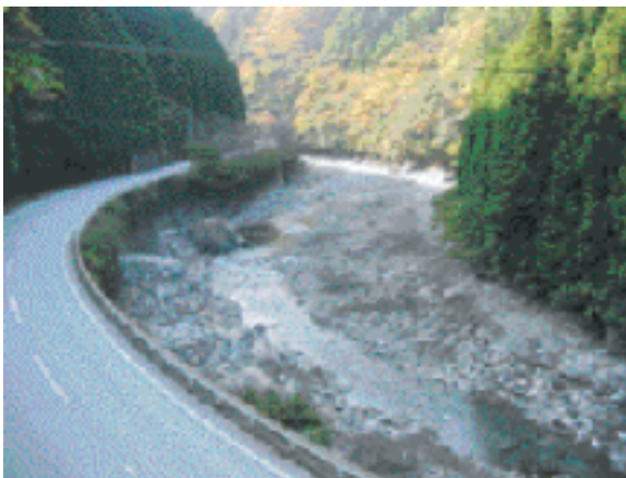
工事完了直後
