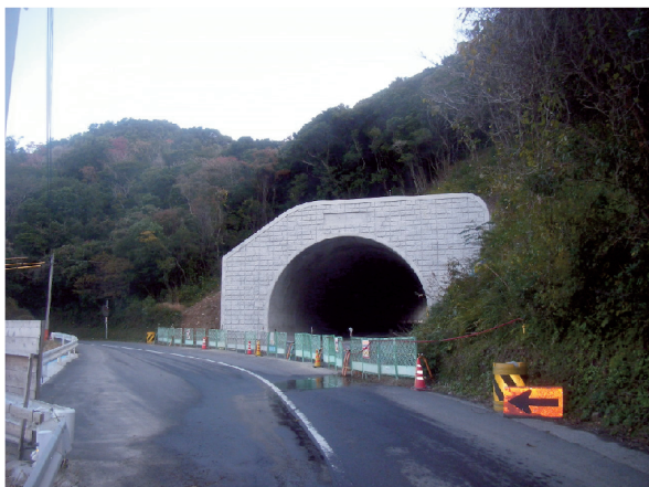
（写真2）周辺景観に配慮した化粧型枠の実施
