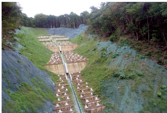
（写真3）間伐材を使用した柵工
