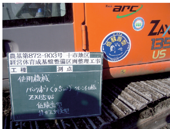
（写真6）排出ガス対策型建設機械の使用
