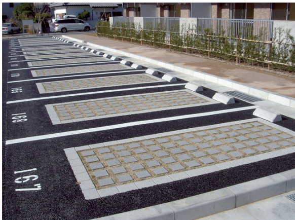
（写真7）透水性舗装とした自然循環等への配慮
