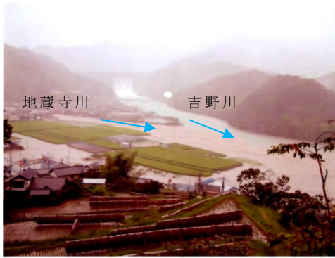
地蔵寺川合流点付近の浸水 (平成 16 年 10 月 20 日)
