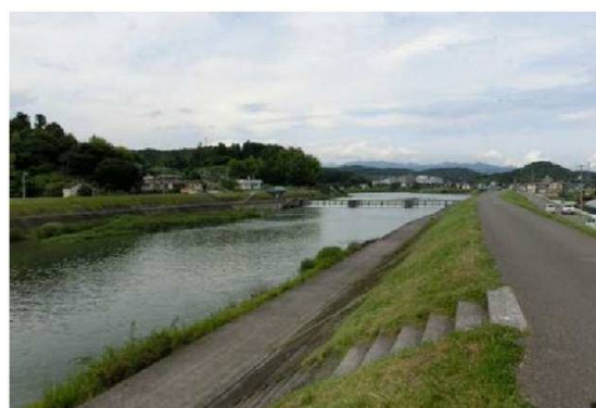
布師田堰下流側の左岸の様子
