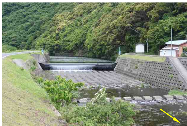
可動堰化された中川原頭首工
