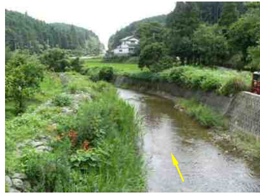
上流域の河道（春遠学橋より下流）
