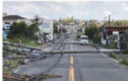
〔平成30年台風第21号(大阪府泉南市)〕
