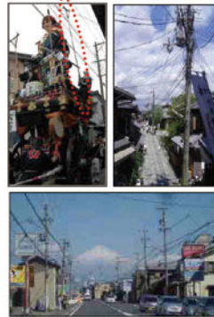
〈美観を損ねる電柱・電線〉
