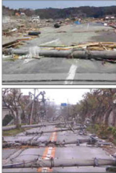
〈電柱の倒壊による道路閉塞〉
