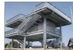
〔津波避難タワー〕
