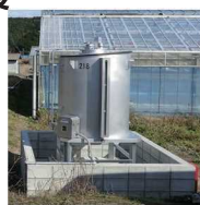
〔津波火災（東日本大震災）〕〔流出防止装置付き重油タンク〕 ※出典：若手県山田町
