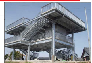
〔津波避難タワー〕
