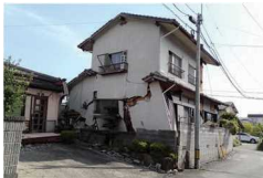
〔熊本地震での住宅被害〕
