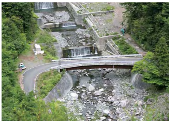
川は森の姿を映し出す鏡、近年の土砂災害により魚道が埋まった治山・砂防堰堤。生態系への影響も心配される。
