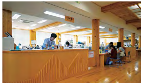
スギの集成材が廊下や壁をはじめ各所に使われている。
