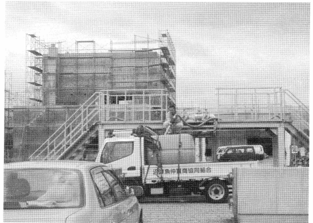
図6 分水施設。後方は建設中の深層水利用施設
