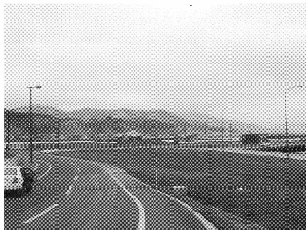
図1 熊石町深層水取水施設周辺（右中程の四角い建物がピット）
