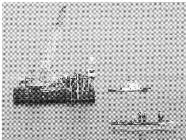
図4 新取水管敷設実験
