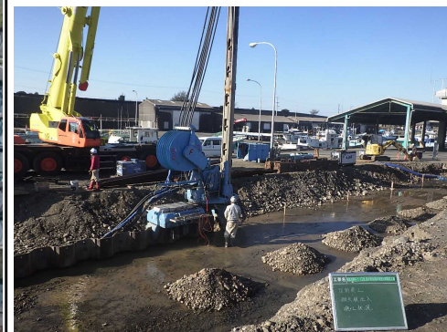
鋼矢板の圧入状況 (硬質地盤への圧入)
